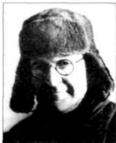
А.Л. Минц на строительстве Куйбышевской радиостанции.
